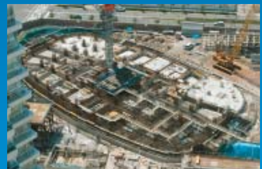
基礎と免震構造、タワー本体の概念図。先の新潟県中越地震でも、免震構造を採用した建築は、ほとんど被害がなかった。05年9月、建設中の『FORESIS』。免震構造の上に高強度コンクリートが打設され、ツインタワーのベースが完成しつつある
